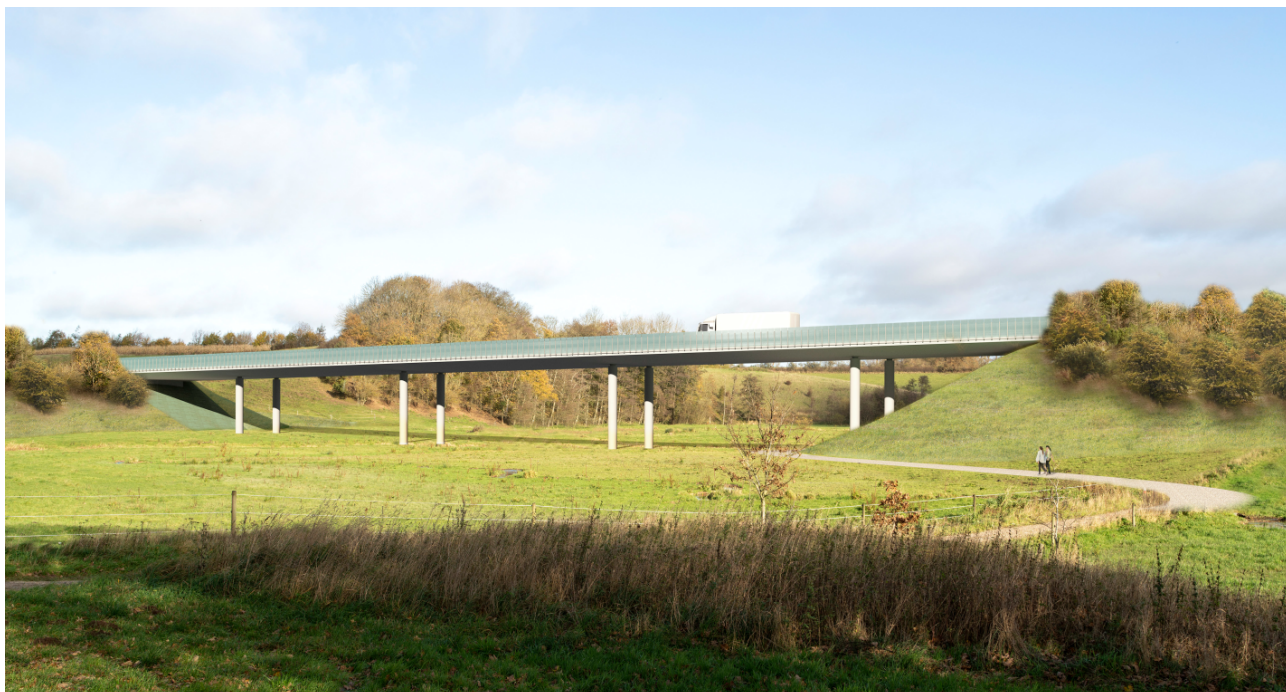
Visualisering af dalbroen med 7-9 meters højde under vejbanen og med tre fag med en bredde på ca. 20 meter. En sådan dalbro opfylder VDs vejlednings krav til gennemflyvning af flagermus i gruppe A-C.
