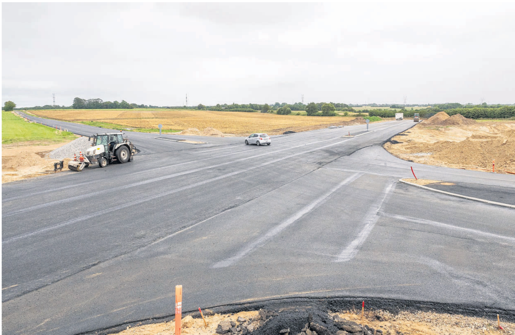
Horsens Kommune har forlænget Mossvej med 1,2 km, så vejen nu er koblet sammen med Vrøndingvej (løber fra højre nederst til venstre øverst i billedet). I forbindelse med anlægsarbejdet har kommunen lagt asfalt syd for Vrøndingvej (øverst i billedet) og har dermed anlagt vej på en strækning, som endnu ikke er politisk godkendt. Foto: Mads Dalegaard
