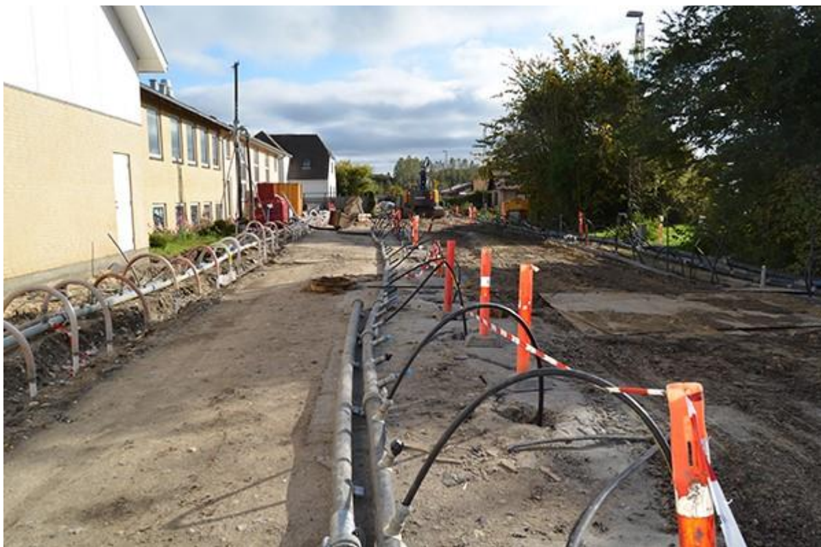
Figur 9-5 Eksempel på grundvandssænkning med reinjektion i lukket sugespidsanlæg (kilde: http://nordjyskgrundvand.dk/grundvandssaenkning/recirkuleringsanlaeg/ ).
