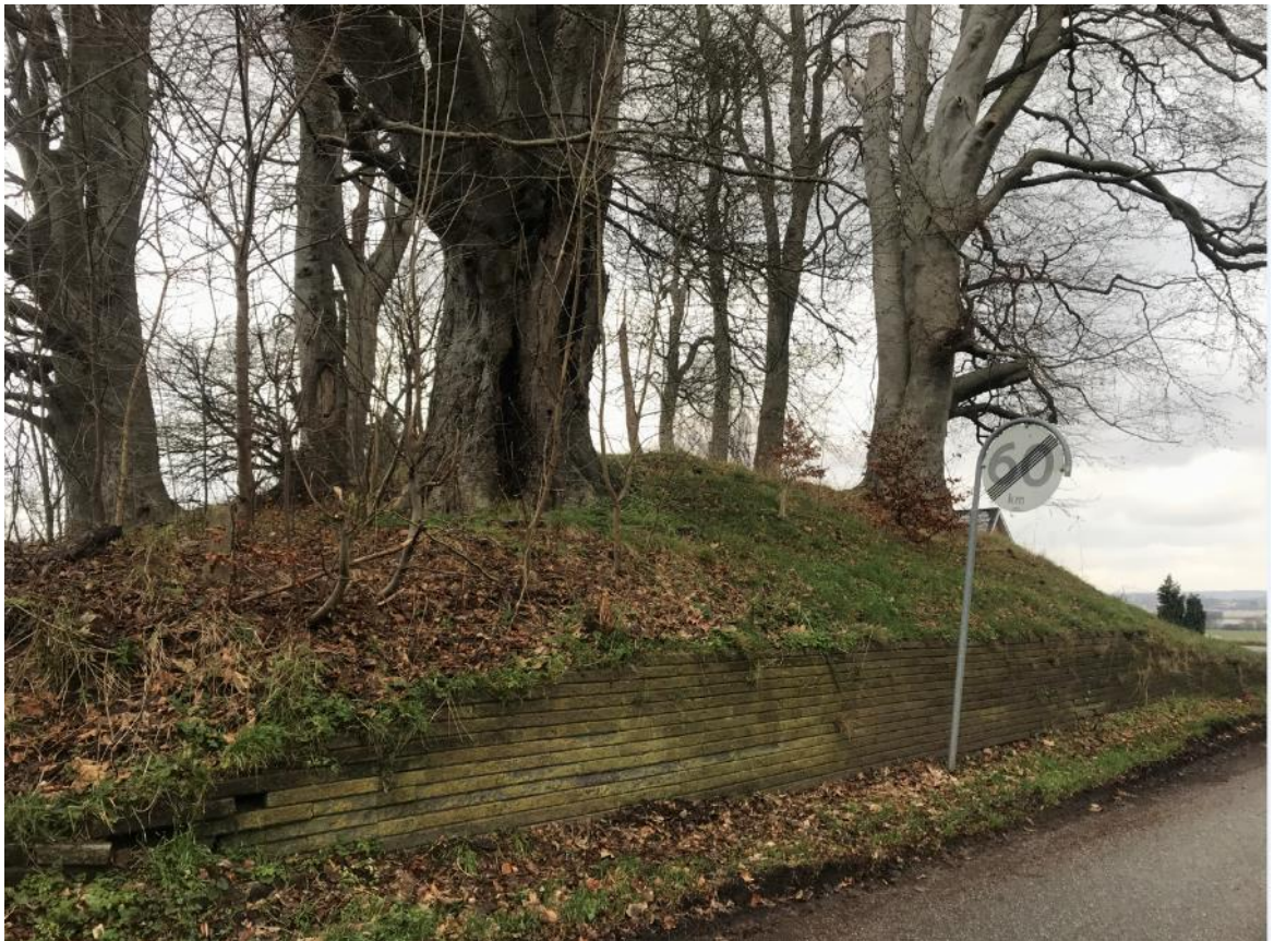
Figur 16-16 Gravhøjen i T-krydset mellem Nordvej og Bollervej har en støttemur mod vejen.
