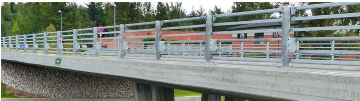
Figur 12-21 Eksempel på hvordan et udfyldt broautoværn principielt kan tage sig ud.
